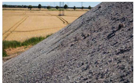
Extrem steile Böschungswinkel und Dammhöhen bis 10 m waren für die Steilkurve notwendig
