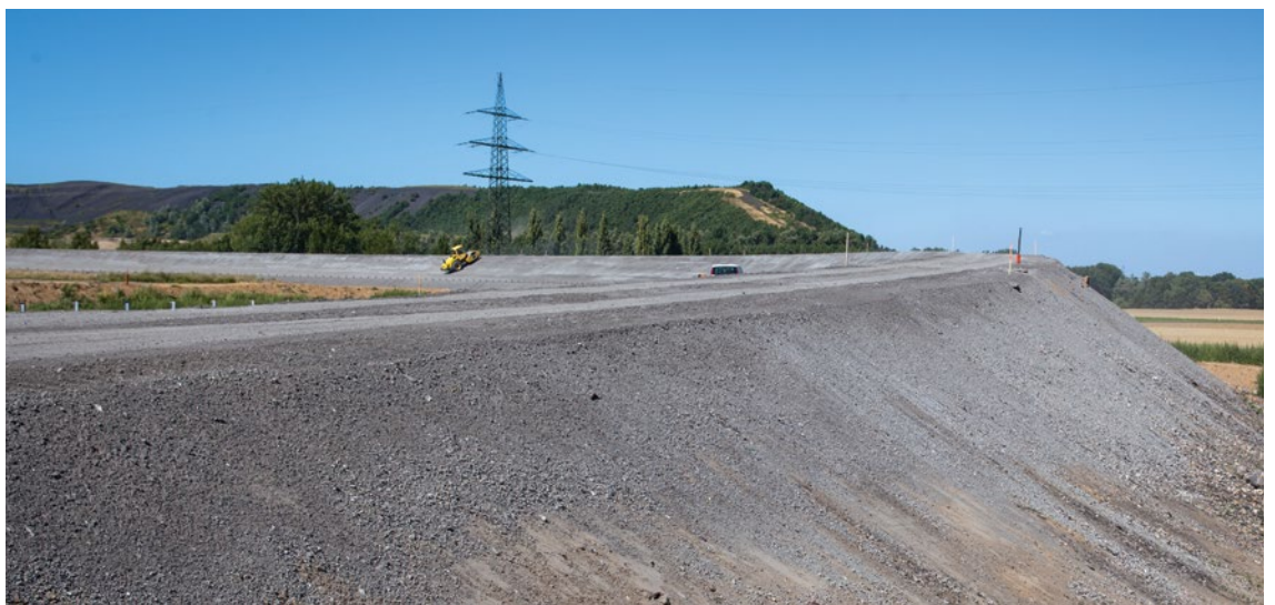
Die Hausmüllverbrennungsasche wurde lagenweise eingebaut und verdichtet, um den geforderten Verdichtungsgrad zu erreichen
