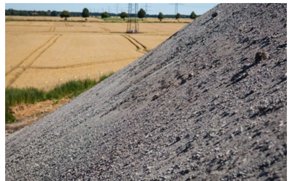
Extrem steile Böschungswinkel und Dammhöhen bis 10 m waren für die Steilkurve notwendig
